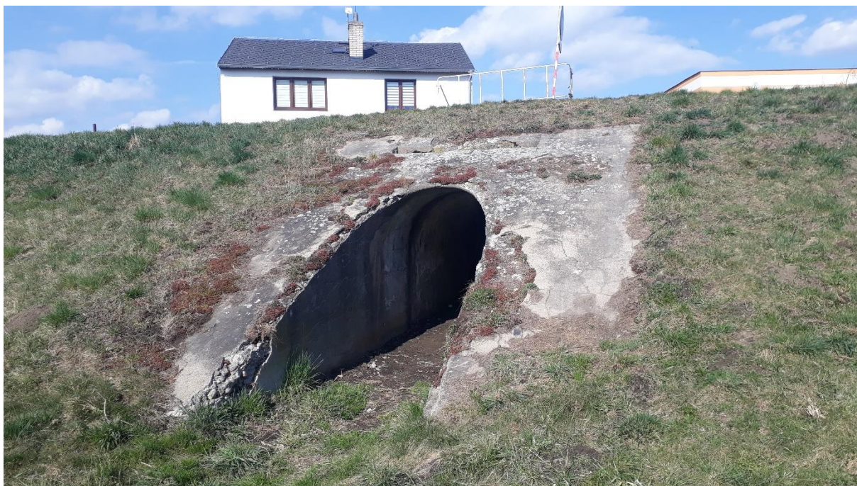
Foto 2 Výúst dešťové kanalizace v km 38,066
